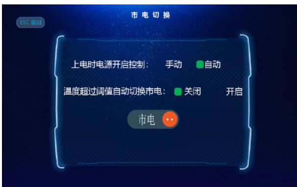
▲ 市电切换：市电和安全电切换操作
